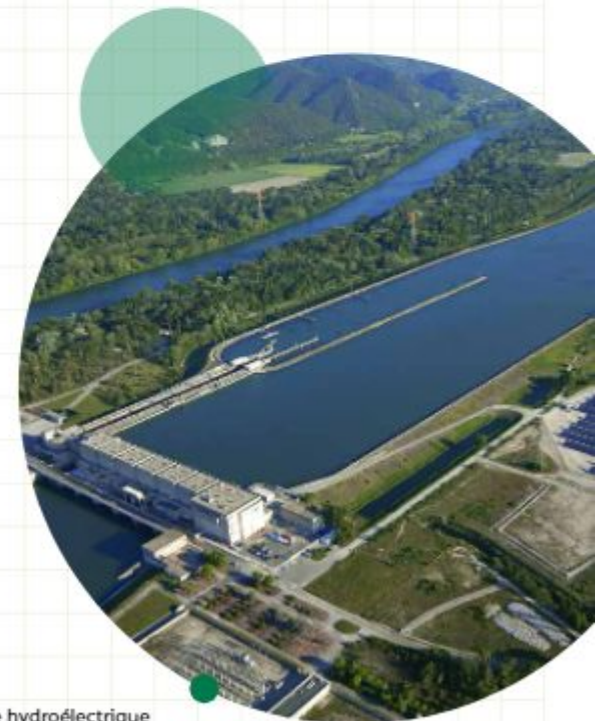
La centrale hydroélectrique de Baix-logis-Neuf et son écluse.
